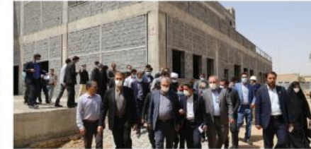
بازدید از پروژه بیمارستان ۱۵۰ تختخوابی رزن
