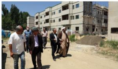
بازدید از خوابگاه در حال ساخت ریحانه
