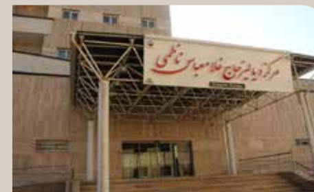
ساخت و تجهیز بخش دیالیز با مشارکت خیر
