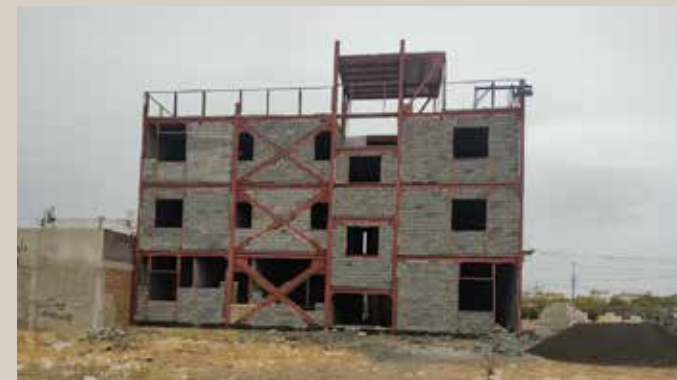
احداث مرکز خدمات جامع سلامت شهرک فرهنگیان بهار با ۶۰ درصد پیشرفت فیزیکی
