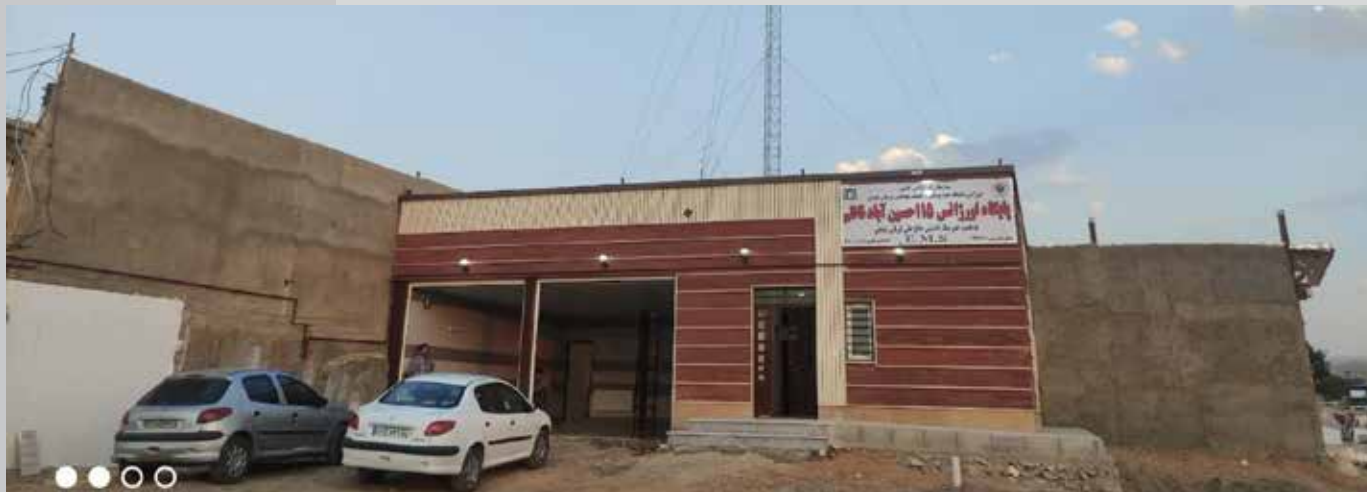
پروژه ساخت پایگاه اورژانس پیش بیمارستانی حسین آباد ناظم
