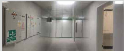
پروژه درحال تکمیل افزایش فضای فیزیکی و تعداد تخت (از بیست تخت به چهل تخت بستری) بخش NICU بیمارستان مهر
