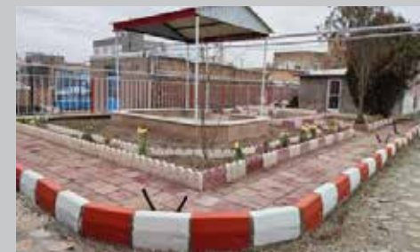
محوطه سازی درمانگاه اعلایی قدیم ۱۶۰ میلیون تومان (در حال تکمیل)
