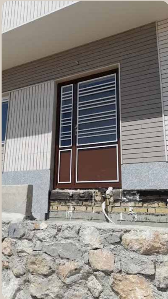
ساخت ۶ خانه بهداشت
