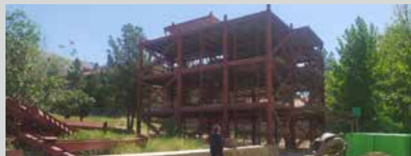
احداث پروژه همراه سرای ۱۱ سوییتی بیمارستان
