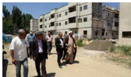
بازدید از خوابگاه در حال ساخت ریحانه
