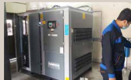
نصب و راه اندازی دستگاه اکسیژن ساز جدید در بیمارستان شهید قدوسی
