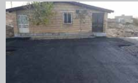
آسفالت محوطه خانه بهداشت و سمسق
