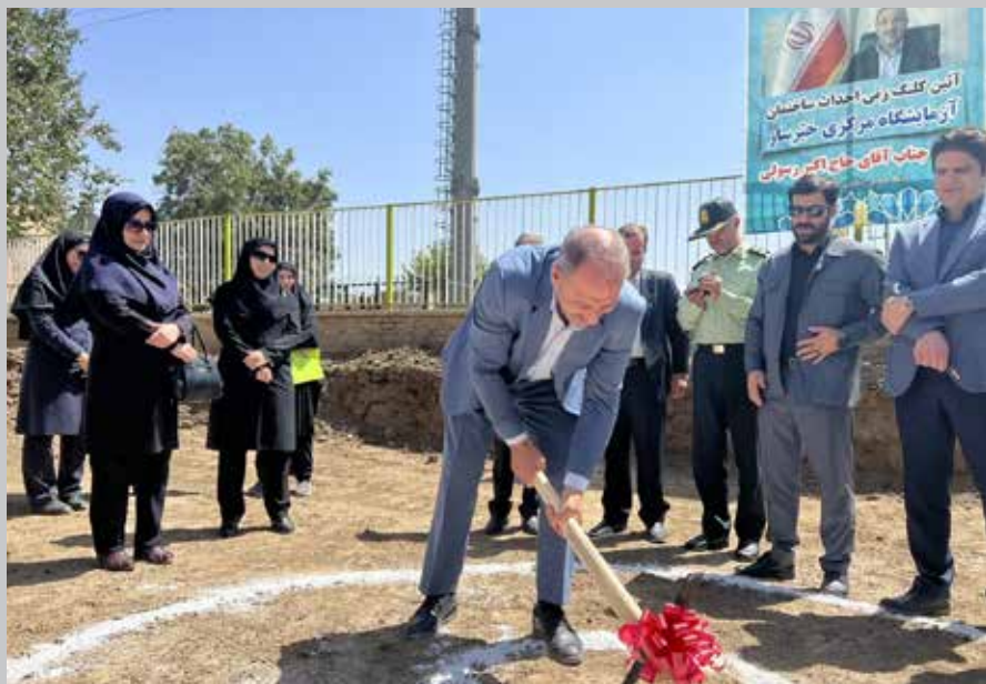
جذب یاریگر سلامت در حوزه بهداشت و کلنگ زنی ساختمان آزمایشگاه مرکزی در هفته دولت ۱۴۰۲ با اعتبار بیش از ۵۰ میلیارد ریال و شروع ساخت پروژه
