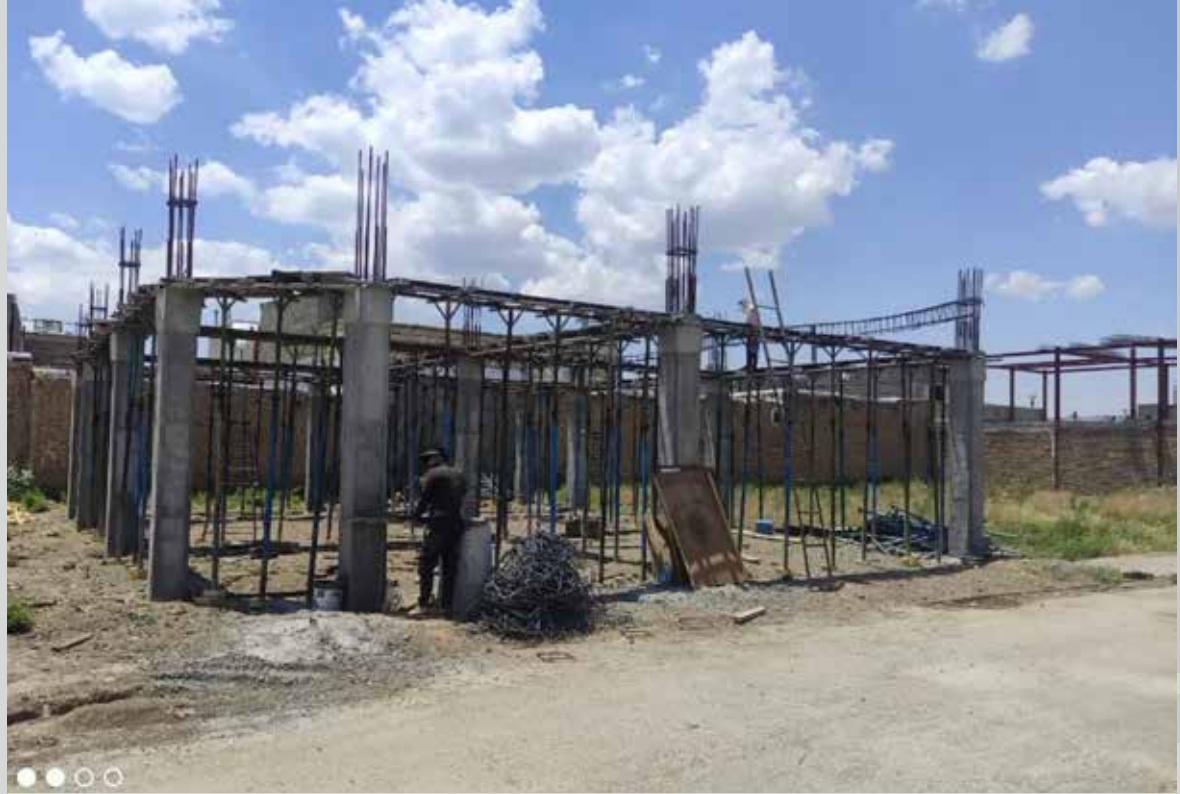
پروژه در حال تکمیل پایگاه اورژانس پیش بیمارستانی شهری ۱۱۵
