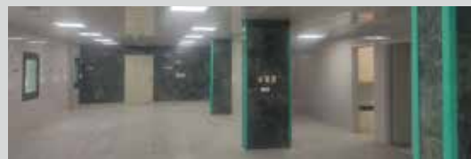
پروژه درحال ساخت بخش پست NICU بیمارستان مهر
