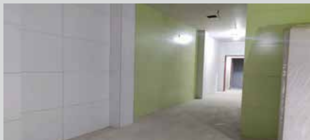
پروژه های نوسازی و گسترش فضای اتاق عمل بیمارستان امام حسین (ع) از ۴ اتاق عمل به ۸ اتاق عمل
