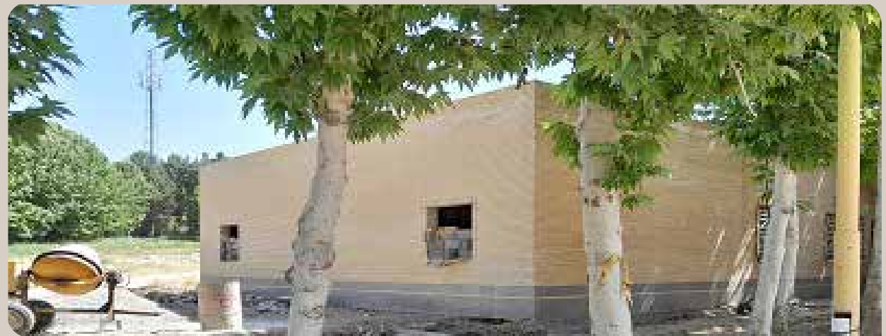
ساخت ساختمان سی تی اسکن بیمارستان آیت اله علیمرادیان
