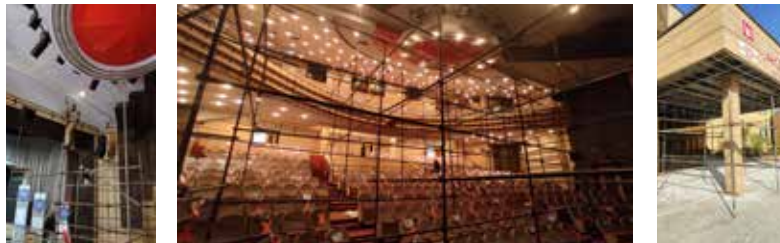
تعمیر و بهسازی فضای فیزیکی و زیباسازی محیط مرکز همایش‌ها
