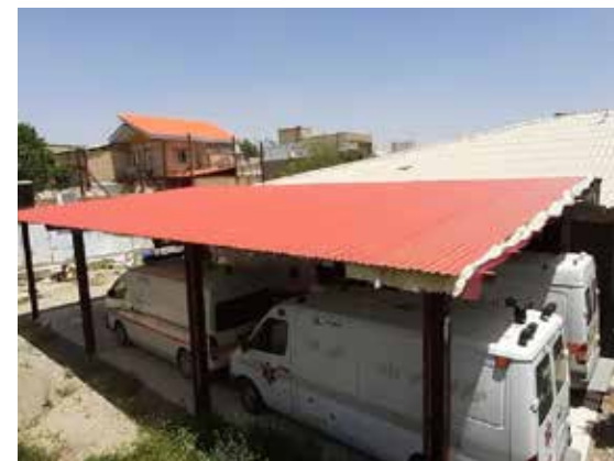
احداث و بهره برداری از پارکینگ و محل شستشو آمبولانس های اورژانس پیش بیمارستانی
