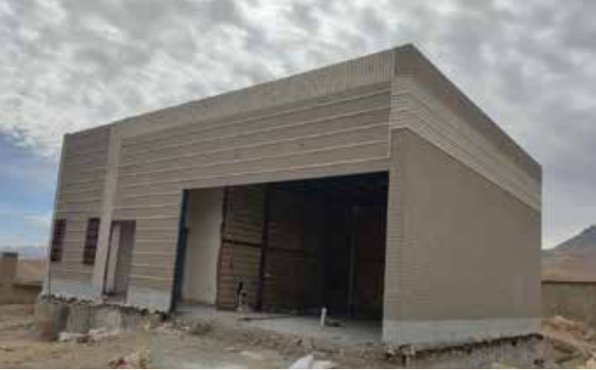
احداث پایگاه فوریت های پزشکی ۱۱۵ جاده ای در روستای همه کسی با ۸۰ درصد پیشرفت فیزیکی
