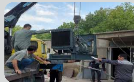
تعمیر دیزل‌های بیمارستان ولی‌عصر و اضافه شدن یک دیزل با ظرفیت ۱۶۵ KVA
