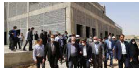
بازدید از پروژه بیمارستان ۱۵۰ تختخوابی رزن
