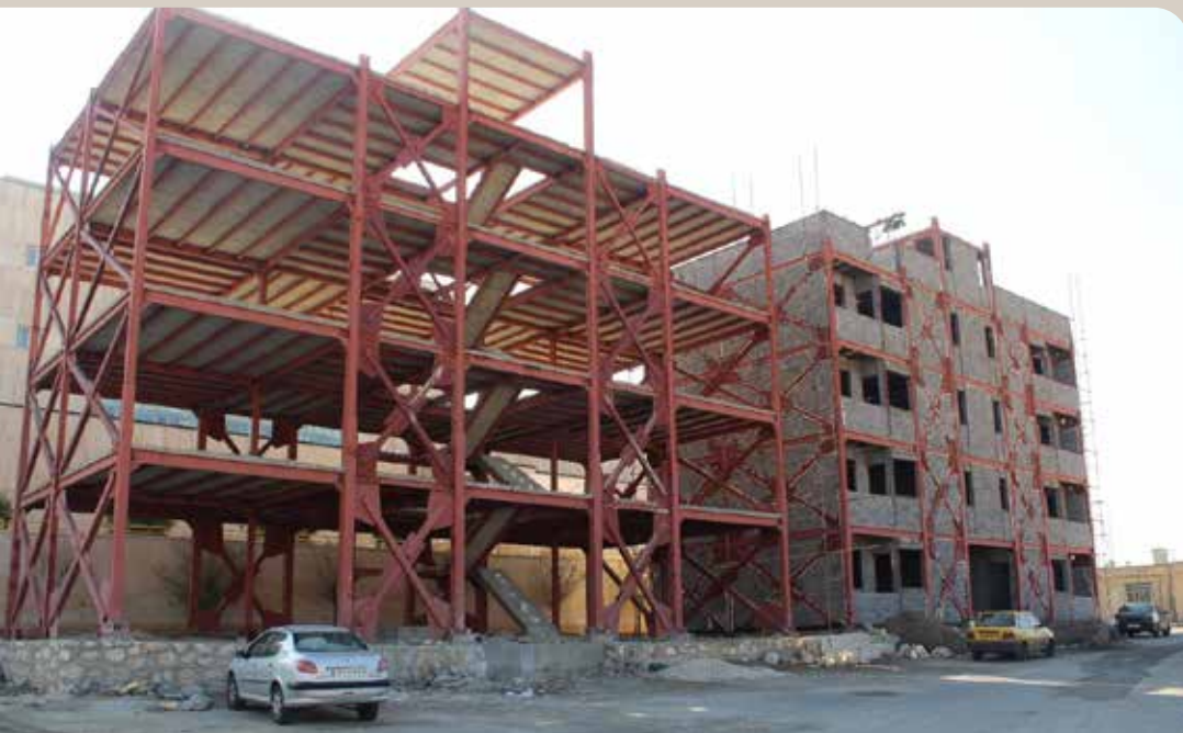
ساخت ساختمان پزشکان بیمارستان شهید قدوسی
